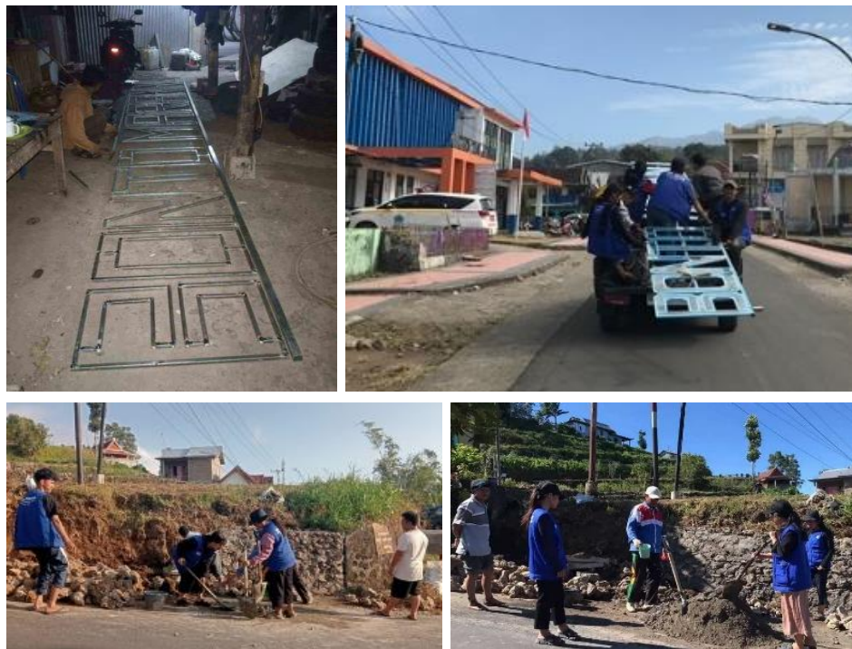
Gambar 2 Proses Pengerjaan Proyek
